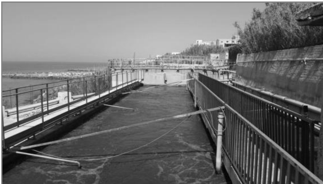
Figura 9 - Vasca di ossidazione da bonificare.
