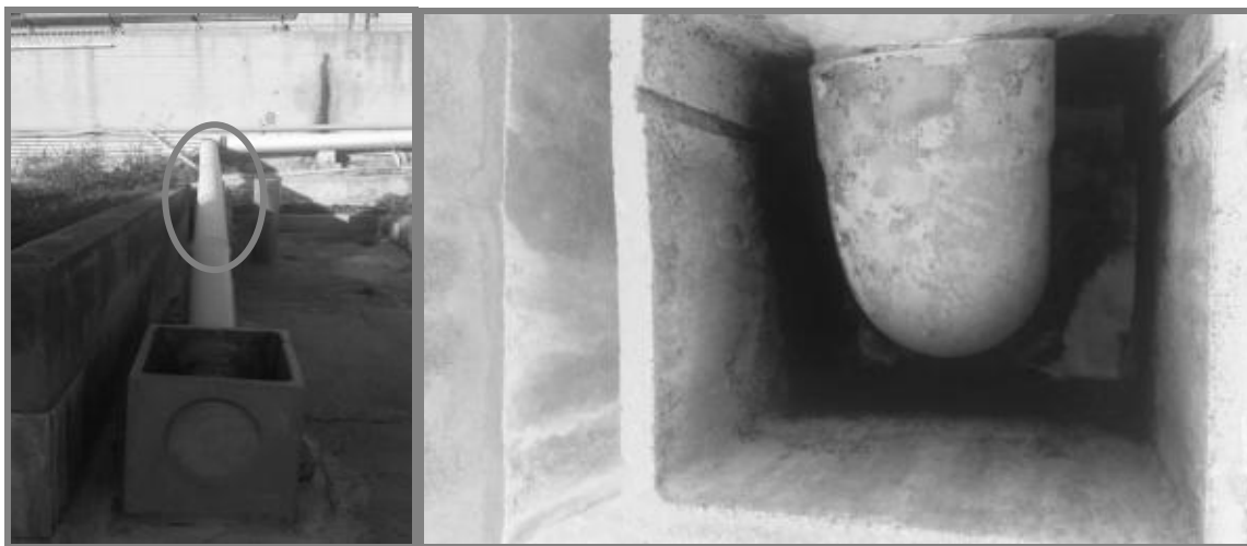
Figura 6 - Punto d'installazione del misuratore di portata e del campionatore automatico.
