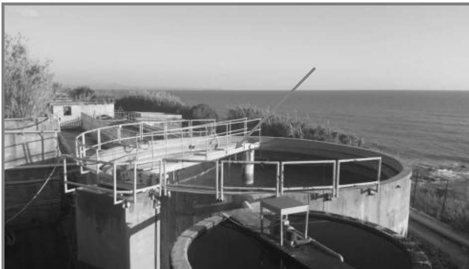
Figura 11 - Sedimentatore primario.
