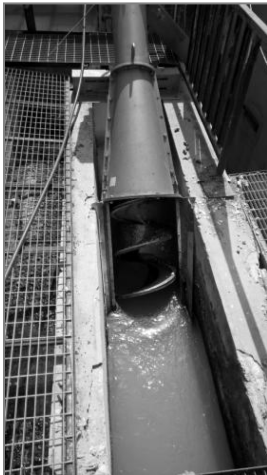
Figura 1 - Canale emissario in arrivo al depuratore.
