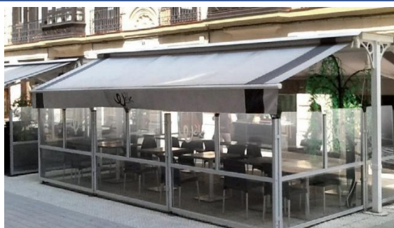
Tipologia B.1: tende a braccio o a scorrimento su binari a copertura delle tipologie A.1, A.2 e A.3
